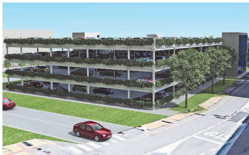
Parking en altura que genera una zona verde de jardín vertical.
